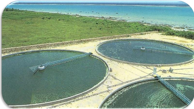
Fotobiorreactores tipo carrusel
